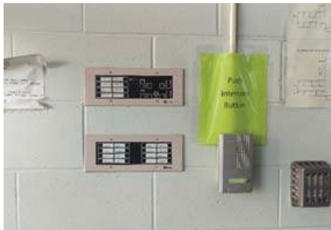
Fire alarm annunciator
